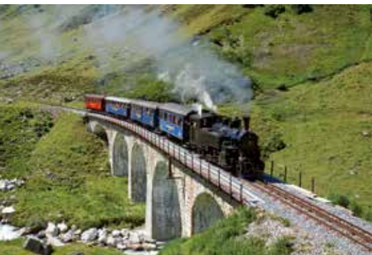
Furka Dampfbahn, Foto: David Gubler, bahnbilder.ch
