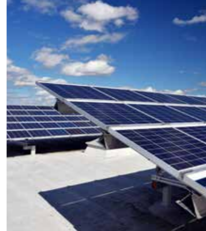
Der Freiblick wünscht sich ein fortschrittliches Projekt in Sachen nachhaltiges Bauen. Von Anfang an war ein ressourcenschonendes und treibhausgasarmes Bauen im Sinne der 2000-Watt-Gesellschaft das Ziel.
