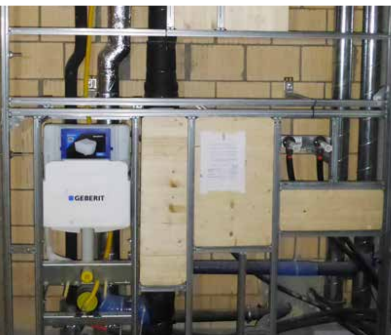
Die Haustechnikinstallation der Nasszellen
