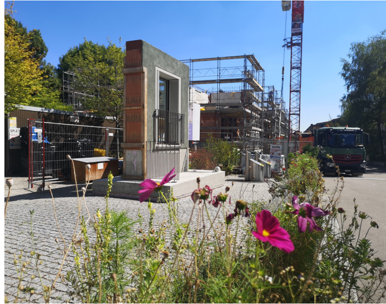
Ein Blick auf die Baustelle im August 2020
