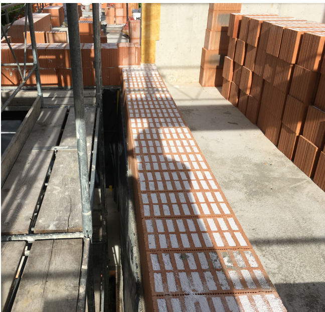
Zur Wärmespeicherung werden ca. 50 cm breite Ziegelsteine mit Perlit aus Vulkangestein gefüllt
